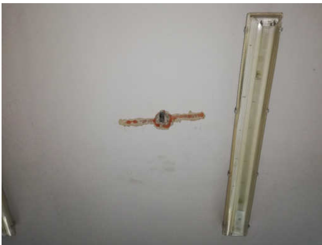
Obr. 16 – Místnost 1.02 dílna, umístění sondy SD1, ověření polohy a rozměrů výztuže
