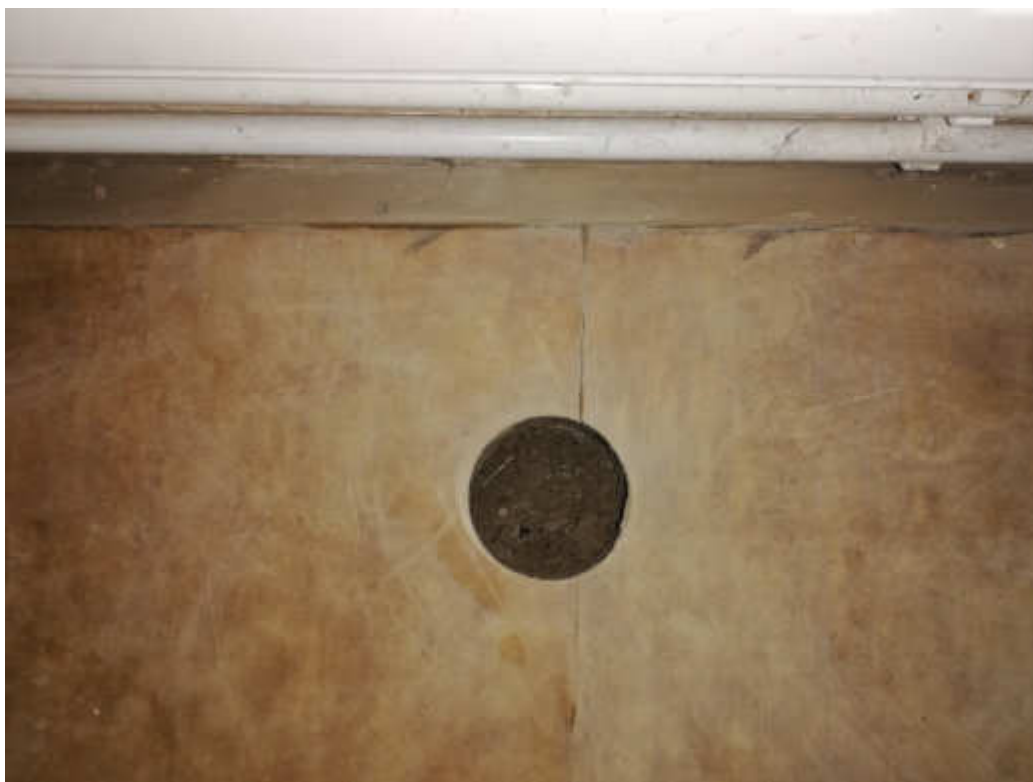
Obr. 22 – Místnost 2.01 Releový sál I, zapravení sondy S3
