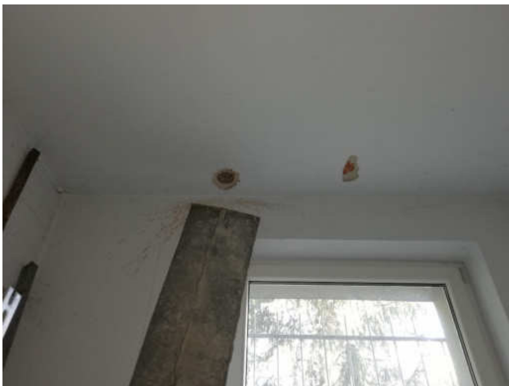
Obr. 7 – Místnost 1.05 Sklad dílny, provrtání skrz sonda S3, vedle úzký kontrolní průvrt stropem
