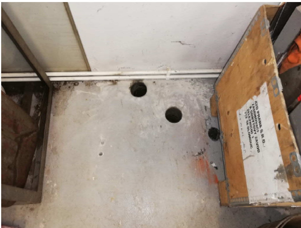
Obr. 1 – Místnost 1.02 dílna, umístění sondy S1 a umístění šikmého vrtu do základu
