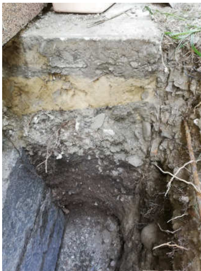
Obr. 14 – JV roh budovy, kopaná sonda S5
