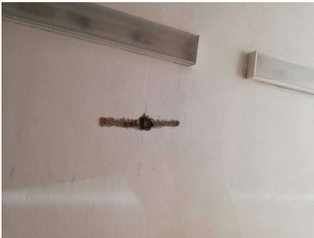
Obr. 18 – Místnost 1.26 vstup, umístění sondy SD2, ověření polohy a rozměrů výztuže
