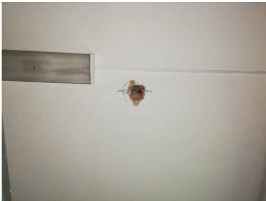
Obr. 20 – Místnost 2.01 Releový sál I, umístění sondy SD3, ověření polohy a rozměrů výztuže
